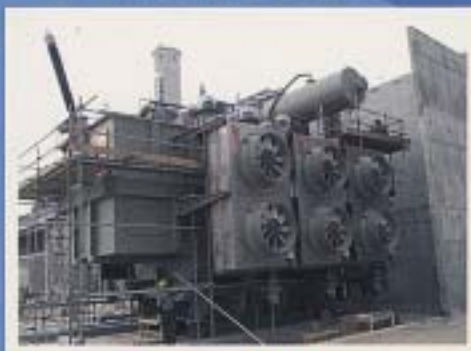
Ölkühlung von Transformatoren Kraftwerk in Saudie Arabien ART mit Gehäuse aus Edelstahl
