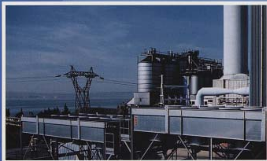
Petrochemie - Etang de Berre 4 ARD mit 4 Ventilatoren Ø 1800 mm
