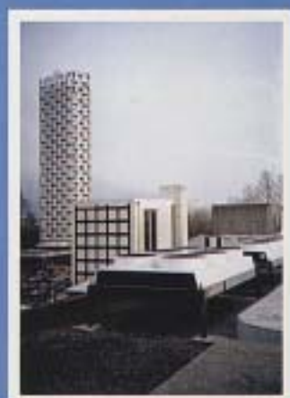
Bürokomplex in Grenoble Verflüssiger mit Regelung über Pressostat
